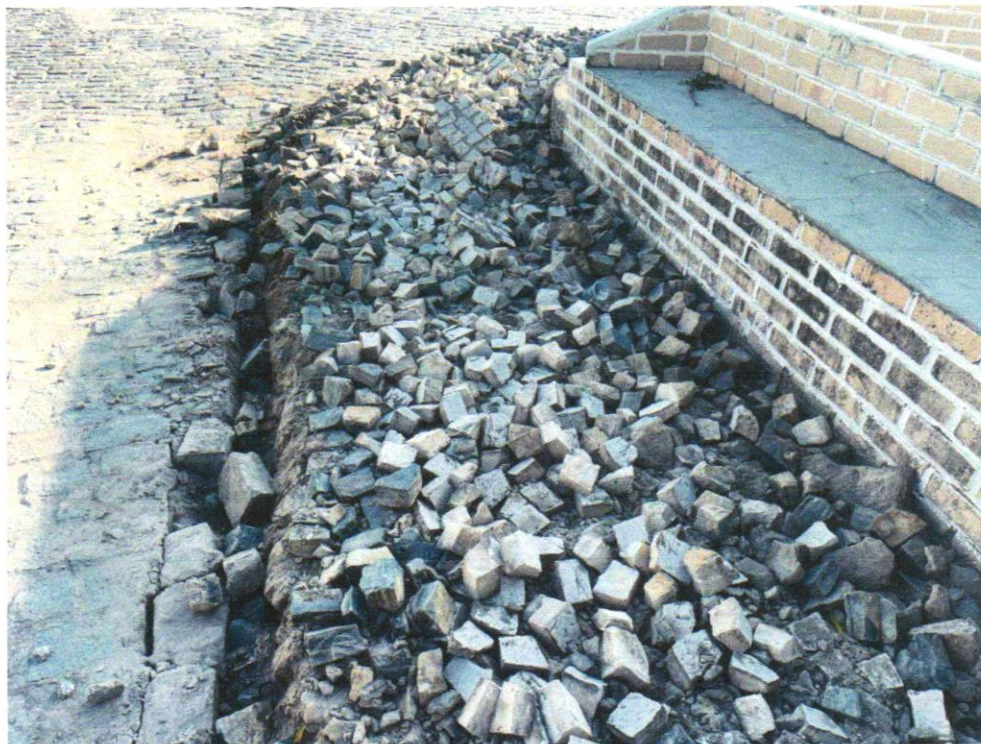
Foto 21 - Remoção de piso em Pedra Portuguesa
