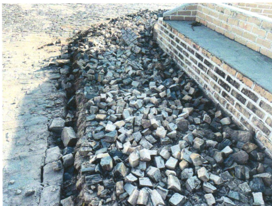
Foto 22 - Remoção de piso em Pedra Portuguesa
