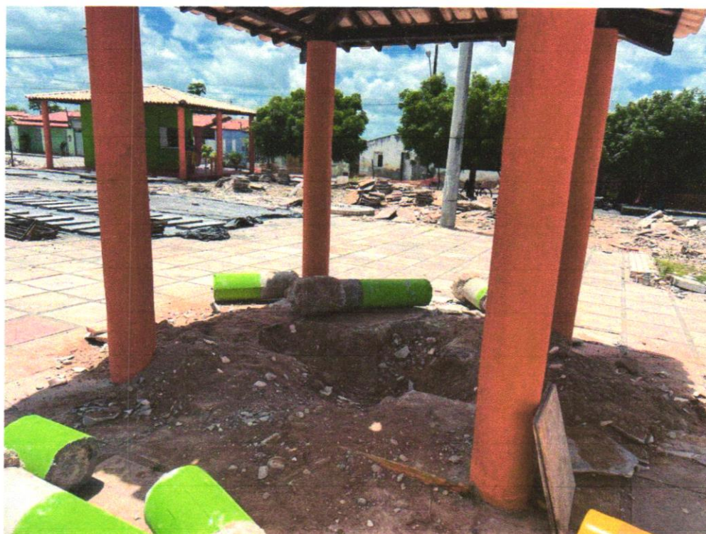
Foto 02 - Demolição de concreto manualmente
